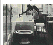
Moderna Una «sala da bagno» nei primi anni Trenta
